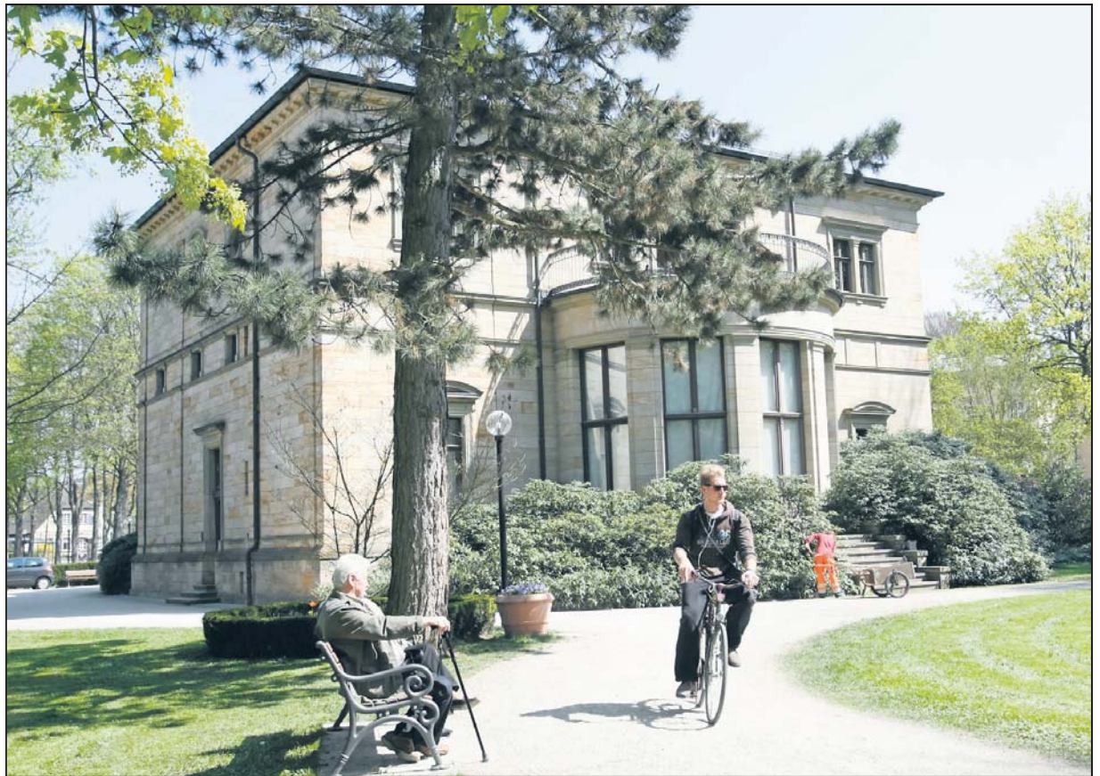
Jetzt noch Idylle, bald schon Baustelle, wenn die Finanzierung steht: Sanierung der Villa Wahnfried und Neubau des Museums, das links von der Villa entstehen soll, werden zwei Millionen Euro teurer als geplant. Foto: Ritter
